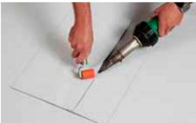
Parametry svařování se musí zaznamenat na zkušební vzorek a uschovat.
